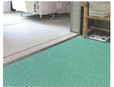
脱衣所の床は水切りが良く、滑りにくい抗菌マットを使用しています。
