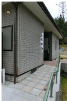
・玄関スロープ
